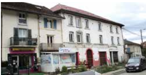
L'Hôtel de la Poste attend la reprise de son chantier de rénovation.
