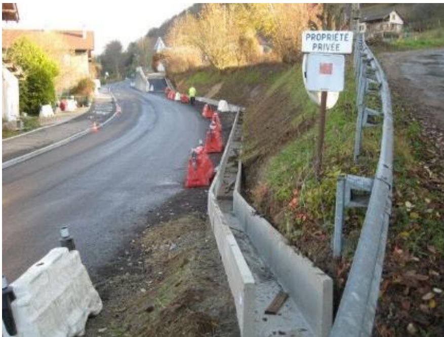
Photo des travaux de mise en place du crapauduc le long de la RD50D
