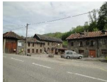
Anc. Taillanderie Brêt en bordure de la Fure – 220 route de Rives. La taillanderie est restée en activité jusqu'à la seconde moitié du XXème siècle - 1827. Ensemble d'ateliers en maçonneries de galets et moellons de mâchefer et béton. Ils sont organisés autour d'une cour et d'une allée en partie nord. Ils abritaient les forges, la tournerie, la scierie, l'atelier de finissage, de meulage et de marquage des pièces/
