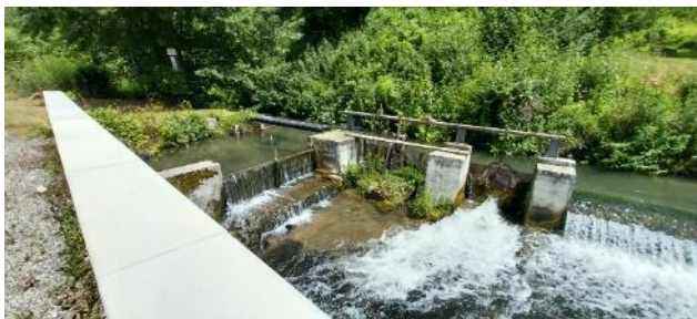
Prise d'eau en L dérivant les eaux dans la traversée de la taillanderie Bret aux Eguebelles en amont de l'ancienne Papeterie Arjo Wiggins – Ouvrage ROE 14309
