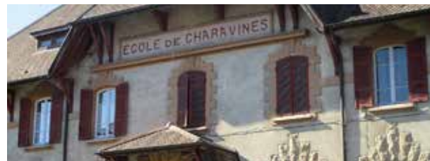
Le changement des menuiseries de l'école devra respecter les qualités patrimoniales du bâtiment.
