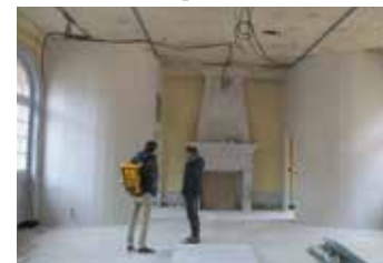
L'aménagement prévoit la création d'un espace sanitaire (au fond à droite) et d'un local technique (au fond à gauche). Il sera installé un écran amovible pour les projections, ce qui permettra de mieux valoriser la cheminée.
