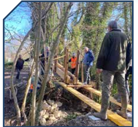
Réalisation des passerelles de la trappe rouge avec les pêcheurs de l'APPMN Haute Fure.
