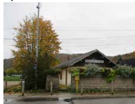
La réorganisation des installations du football permet d'agrandir le parking des Bains
