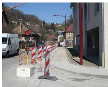
Nouveau trottoir rue Principale.
