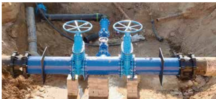
Chaque année des conduites d'alimentation en eau potable sont renouvelées.
