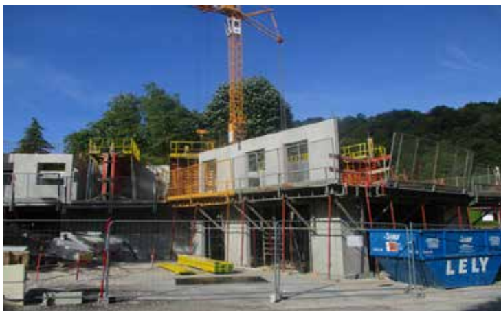
Les deux petits immeubles à côté de la future mairie offriront 9 nouveaux logements au cœur du bourg.
