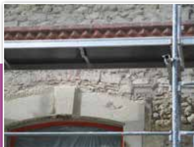
Un appareillage qui n'a jamais été pensé pour rester apparent.
