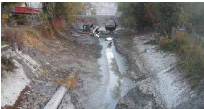
Le curage du canal exutoire en 2017.
