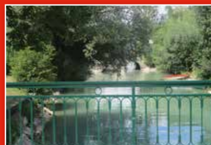
Une nouvelle barrière pour le pont des vannes.
