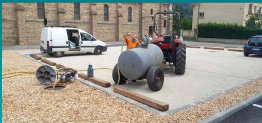
L'équipe technique utilise l'eau de la nouvelle citerne du Clocher.
